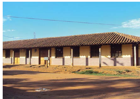
Das neu gestrichene Schulgebäude
